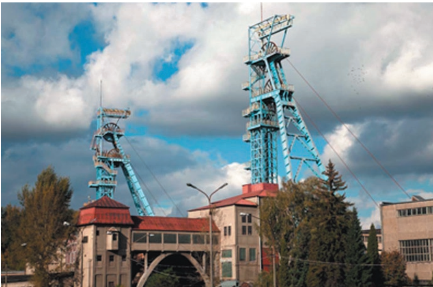
Pracovníci spoločnosti Tubau pracujú v Poľsku aj pre baňu PG Silesia v meste Czechowice-Dziedzice, 40 kilometrov severovýchodne od Českého Těšína
