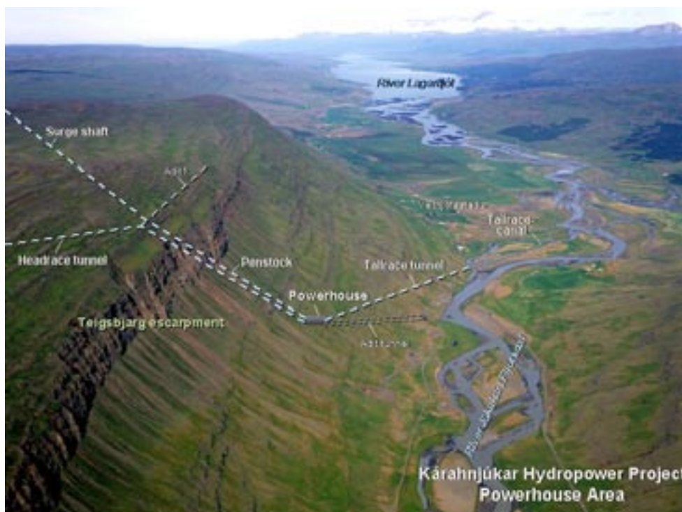
Projekt výstavby podzemnej elektrárne Kárahnjúkar na východe Islandu.
