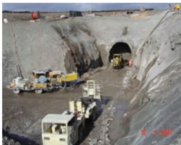
Škótsko, Glendoe. Aqueduct Tunnel 2.
