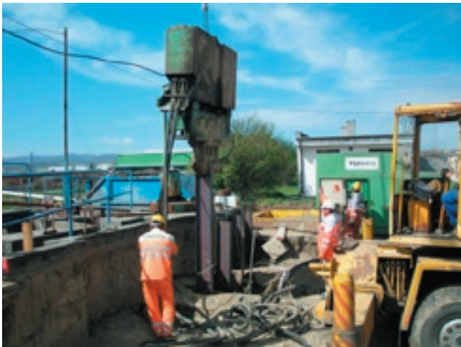
Zhotovenie záporového paženia pre objekt lapača piesku a tuku.
