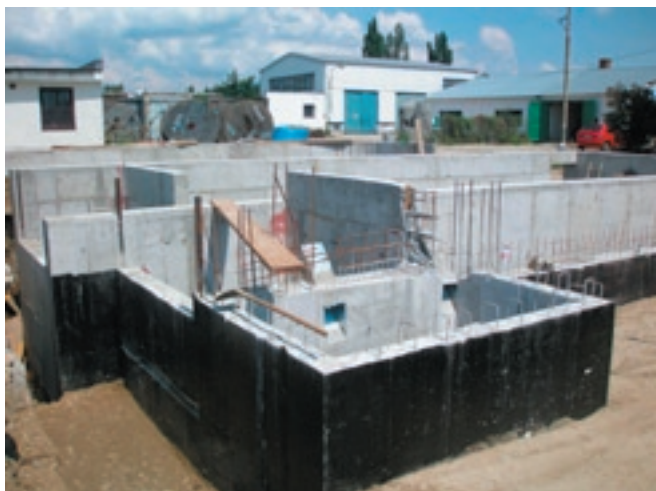
Lapač piesku a tuku počas betonárskych prác.
