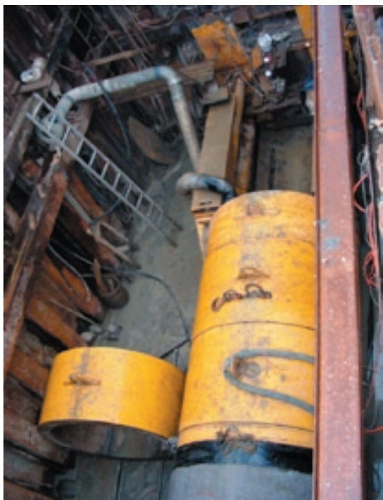
Pohľad do štartovacej jamy č.58 s pretláčacou súpravou vo fáze zatláčania ŽB rúry.
