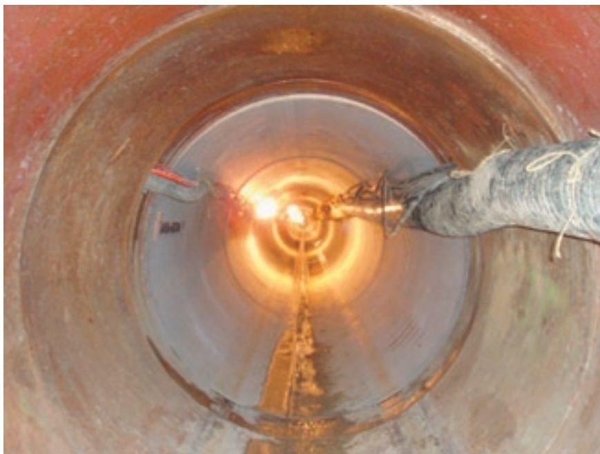
Pretláčaný úsek zo železobetónových (ŽB) rúr s vnútorným priemerom DN 1500 (pohľad od čelby do zatláčacieho britu).
