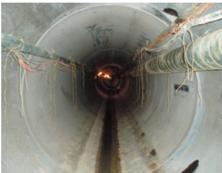
Pretláčaný úsek zo ŽB rúr s vnútorným priemerom DN 1500 (pohľad k čelbe od štartovacej jamy).
