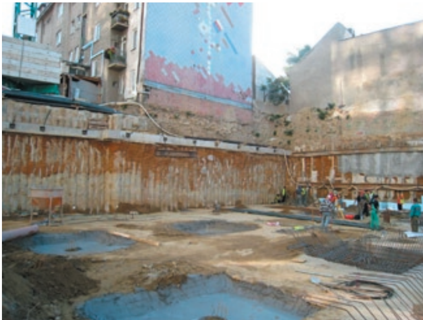
Paženie stavebnej jamy
