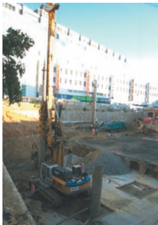
Realizácia pilót – hĺbkové založenie objektu
