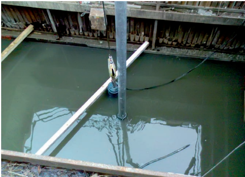
Obr. 2 – Zatopená šachta Š-52
