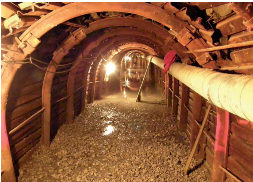
Obr. 1 – Razená chodba zo zabezpečeným stropom prostredníctvom UNION paženia
