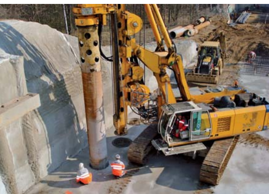
Žilina Europalace – realizácia základových veľkopriemerových pilót
