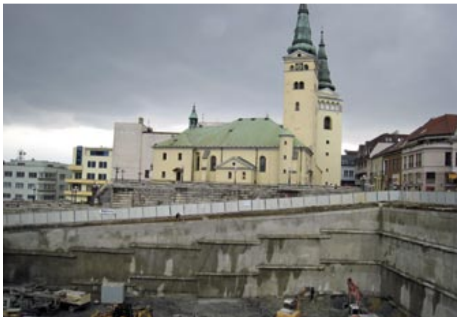
Pohľad na paženie jamy, výkop tretej kotvovej úrovne steny od Farských schodov
