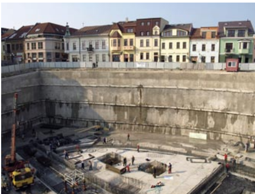
Pohľad na paženie steny stavebnej jamy od ulice Dolného valu
