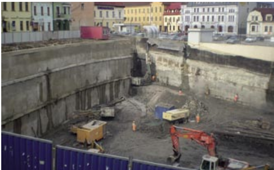
Vrtanie zápor záporovej steny od garáží Kálov vrtnou súpravou Cassagrande
