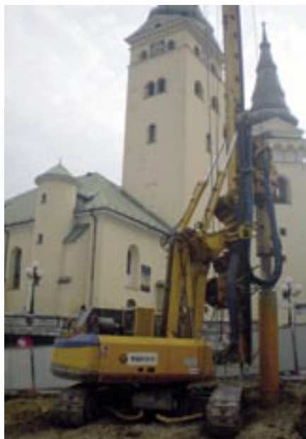
Vrtanie pilót pažiacej steny vrtnou súpravou Bauer BG
